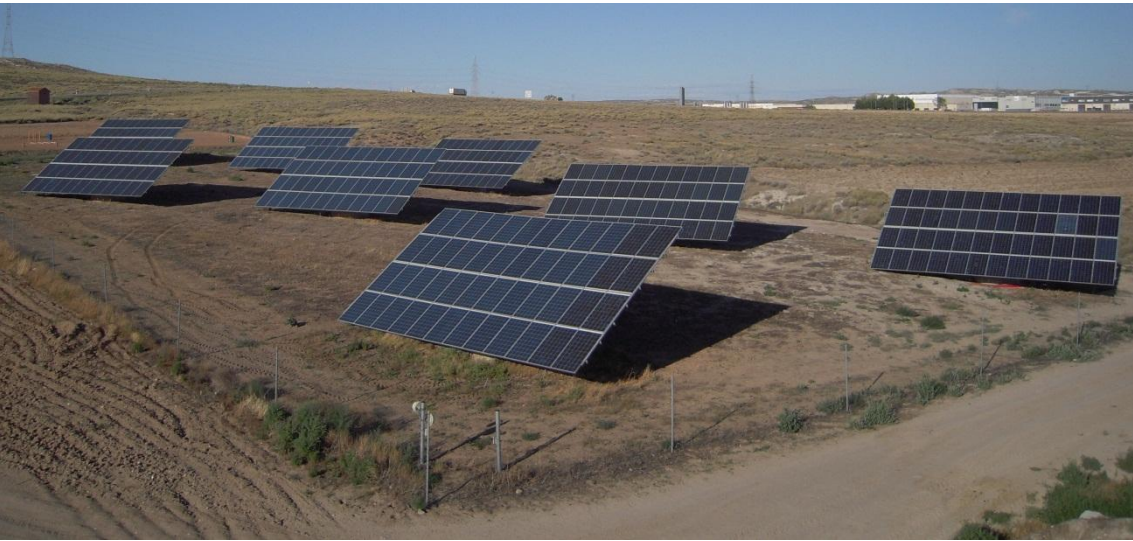
Fotografía 1. VISION PANORAMICA DE LOS OCHO MODULOS INSTALADOS EN EL TERRENO DE MI PRINCIPAL.
